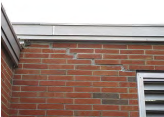
Replace Masonry
